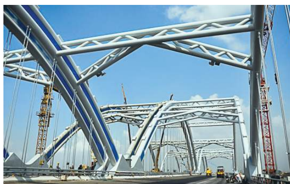
Ứng dụng làm cầu đường Applications in Bridges
